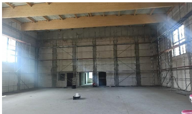
Sala gimnastyczna w budowie (własne)
