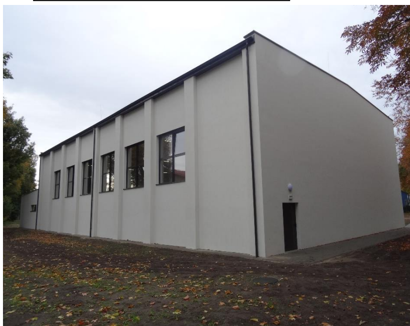
Budynek sali gimnastycznej po wybudowaniu (własne)
