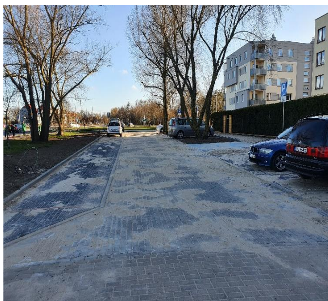
ul. Brukselska po przebudowie (własne)
