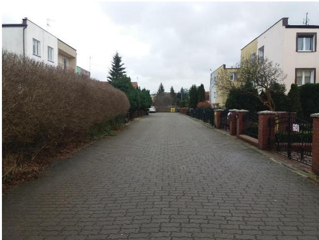
ul. Gdańska - przed przebudową (własne)
