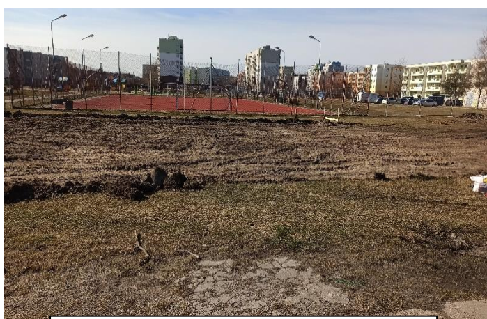
Teren przed rozpoczęciem budowy (własne)
