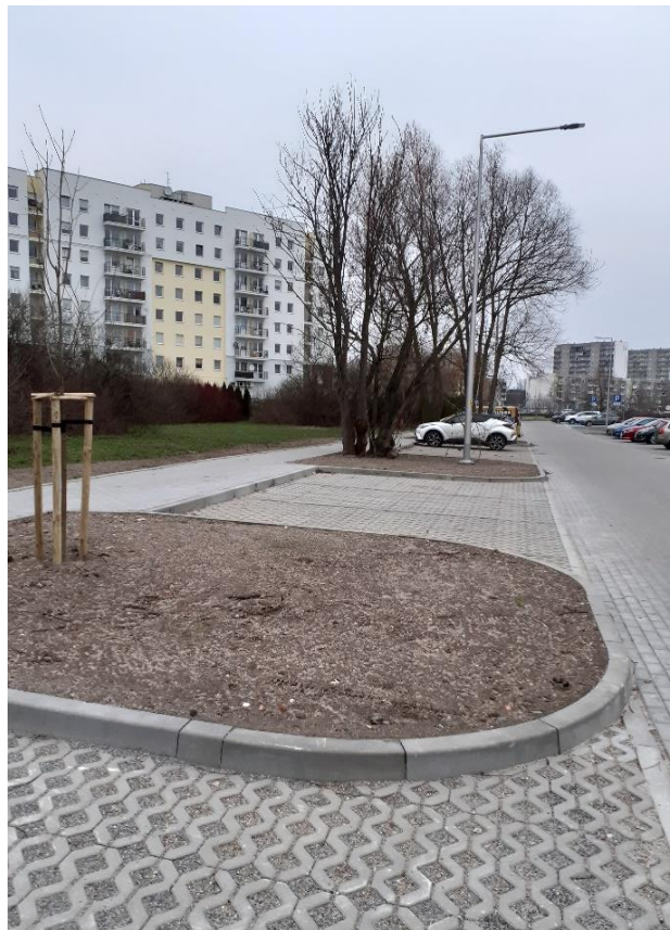
ul. Wybickiego po budowie (własne)
