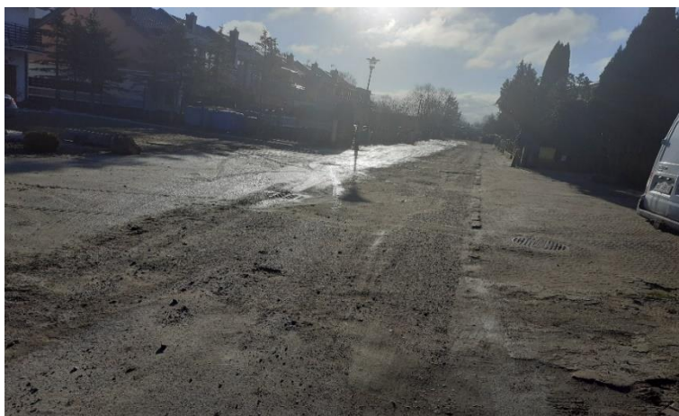
ul. Wesolej w trakcie przebudowy (własne)
