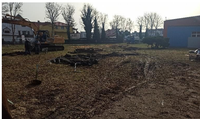
Teren przed rozpoczęciem budowy (własne)
