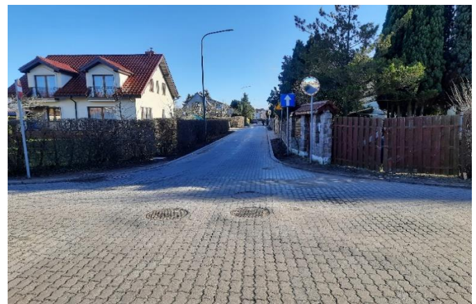
ul. Poznańska po przebudowie (własne)
