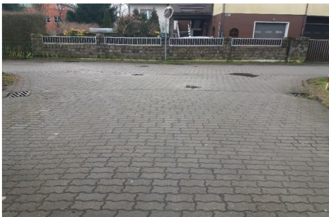
ul. Poznańska przed przebudowa (własne)
